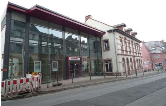
Abb. 2: Bebauung/Nutzung im Plangebiet/Kulturhalle
